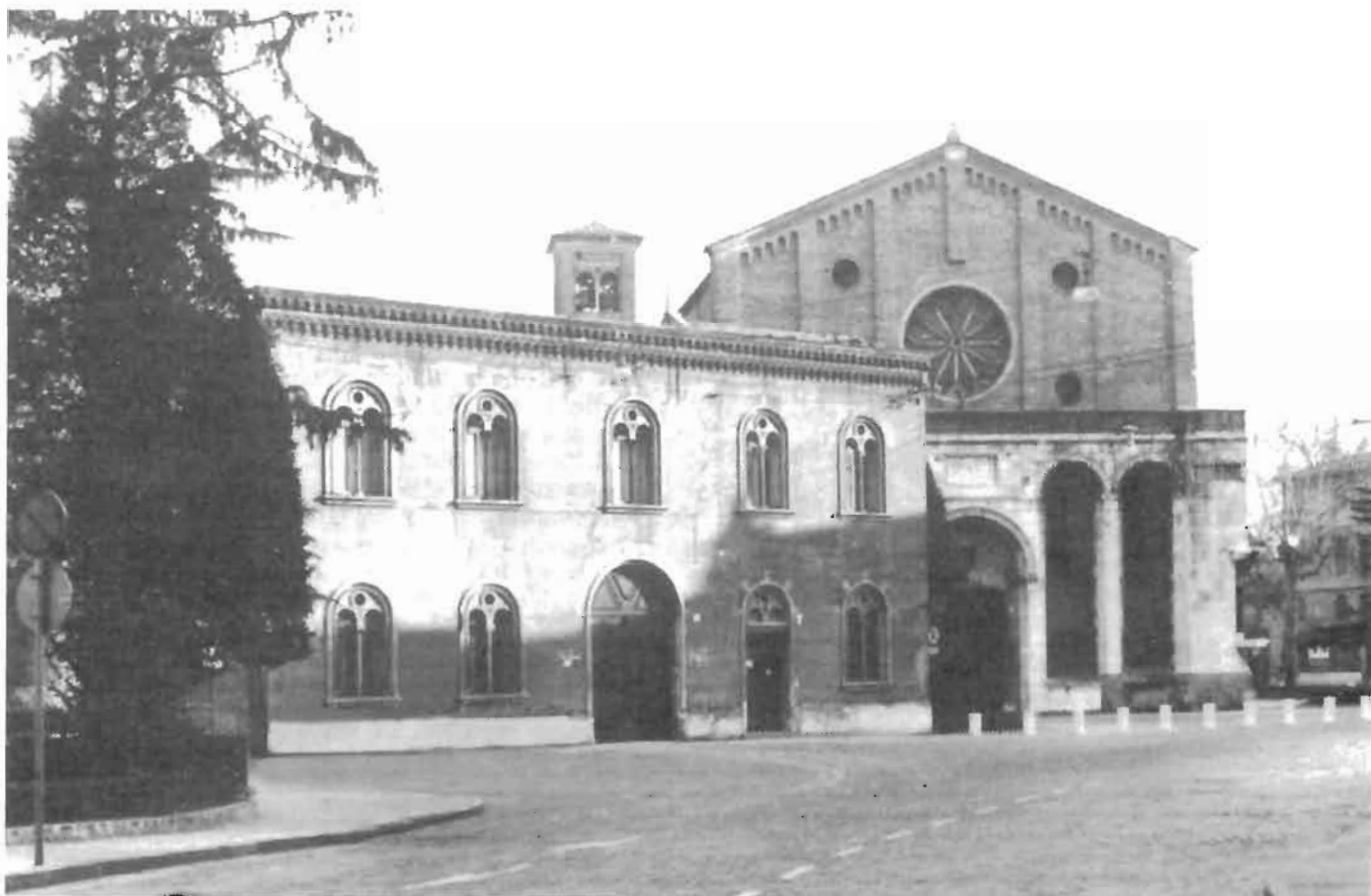
La chiesa degli Eremitani come appariva in seguito al bombardamento del 1944, e nel suo assetto dopo la ricostruzione, col preesistente avancorpo.
