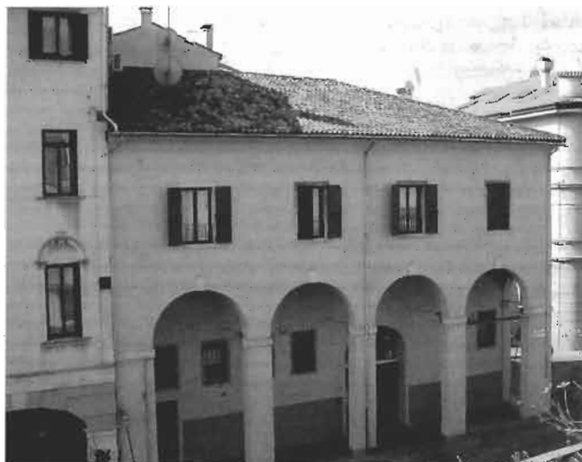
6. Padova, Riviera Tiso Camposampiero, n. 10-11. Facciata dell'ex scuderia del palazzo Manin (foto V. Noaro).
