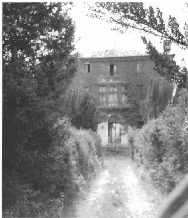
Villa Mocenigo di Abano Terme, oggi in stato di estremo abbandono.
