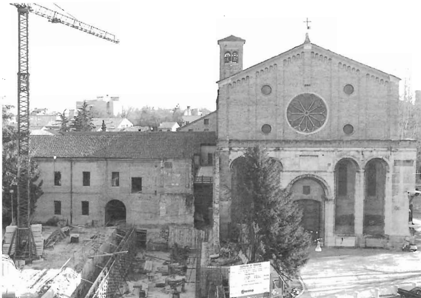
La chiesa degli Eremitani e l'adiacente complesso museale come si presentavano dopo la demolizione del Distretto militare, mentre era in corso la costruzione del nuovo avancorpo, poi interrotta. L'aspetto non è molto dissimile dallo stato attuale.
